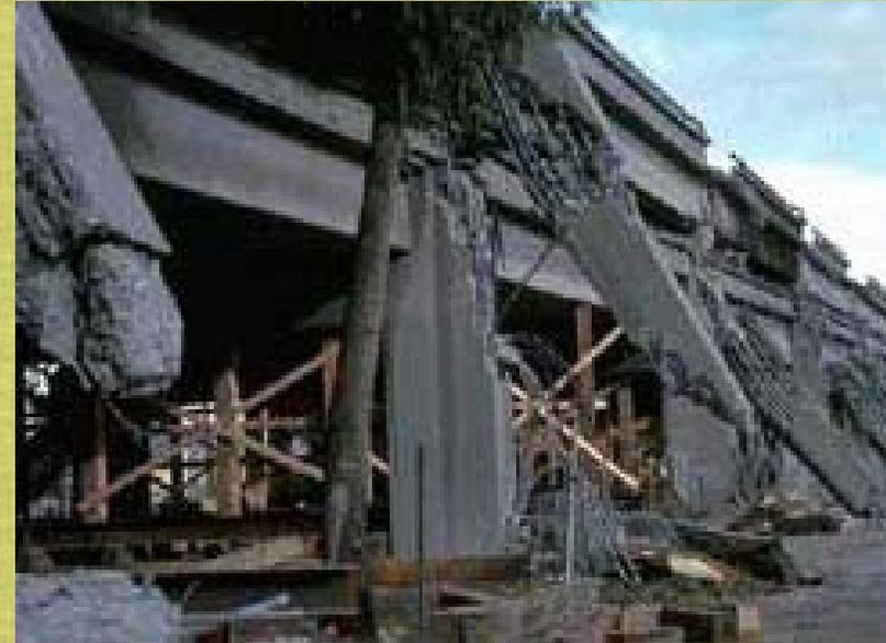
يعتبر سوء تصميم و تنفيذ العقد من أكثر الأسباب الإنشائية التي أدت إلى انهيار العديد من المنشآت، و من الملاحظ أن عدم كفاية التسليح العرضي و/أو الطولي هي السمات المميزة لانهيار العقد، و أحياناً تكون الممارسات الخاطئة في تخريب المقطع البيتوني من الأمور التي تساهم في الانهيار. (يقصد بالعقد مواقع تلاقي العناصر الإنشائية، و بشكل خاص منطقة تقاطع العمود مع الجائز.)
